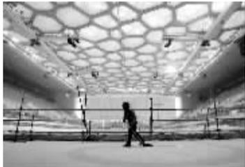
“水立方”的外膜是软软的一层，很多人禁不住要问，它的坚韧度怎样？如果遇到烟火、冰雹、刀割等异常情况，会不会在使用中出现问题？中方设计师赵小钧对“水立方”的安全充满信心：“冰雹是有实验证明的，在德国有过一次很大的冰雹，像鸡蛋那么大，有照片为证，很多汽车被砸得一塌糊涂，有一个房子的屋顶是用这种材料做的，只有那所房子的采光天棚基本上没受影响，只不过是那个膜上稍微留下一点痕迹而已，所以外膜对冰雹的承受度是很高的。”
