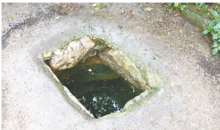
扳倒井的井筒与地面约成45度夹角，村民于去年对井口进行了改造。
