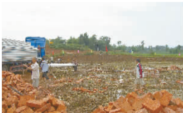
援建队正在施工。
