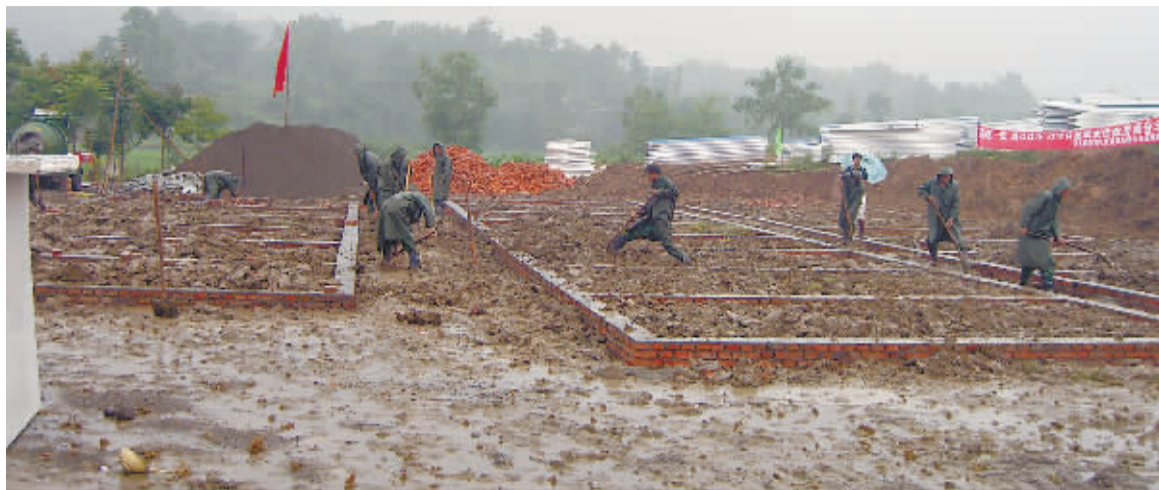
援建队施工现场。
