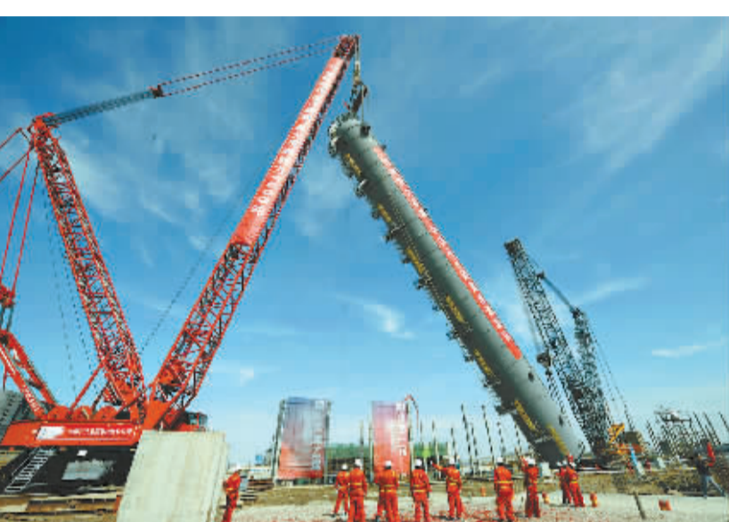
“中华第一吊”在天津首吊千吨塔
