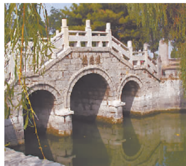
禹王庙前的怀禹桥
