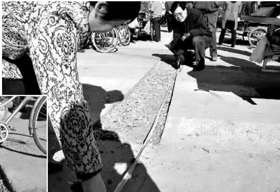
的路上测量“马路拉链”的长度、宽度。
