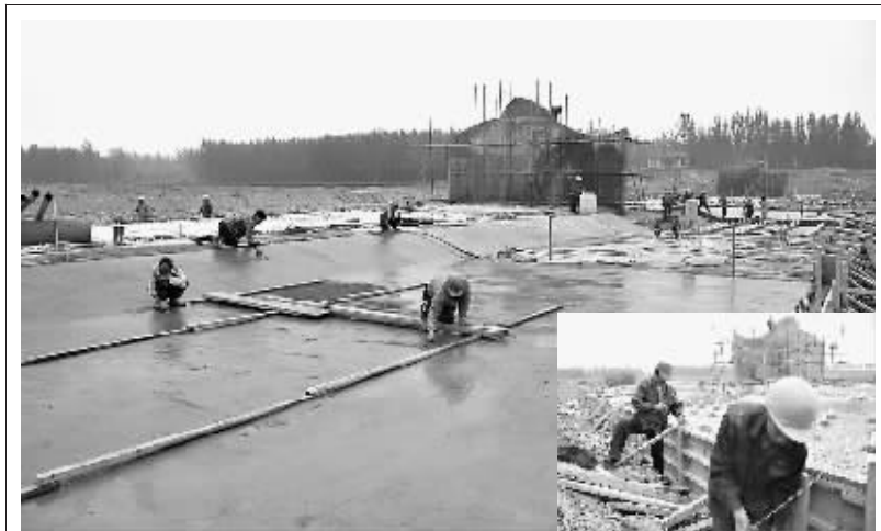
4月14日,河南省水利第一工程局施工人员正在淇河橡胶坝建设工地施工。淇河橡胶坝位于浚大公路桥下320米,设计坝长211米,可拦蓄水量190万立方米,最大挡水深度4.5米,回水长度3.1公里,可回水至花窝拦河坝。该工程去年年底开工建设,目前坝体和消力池混凝土浇筑已基本完工;控制室电控系统正在安装调试,上游河道治理5月底完工,目前已完成总工程量的70%。 晨报记者 赵永强 摄
