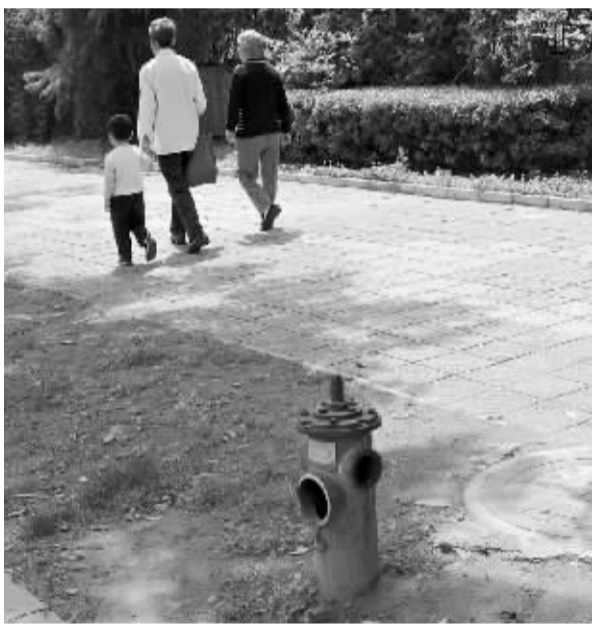
新区九州路上的破损消防栓
