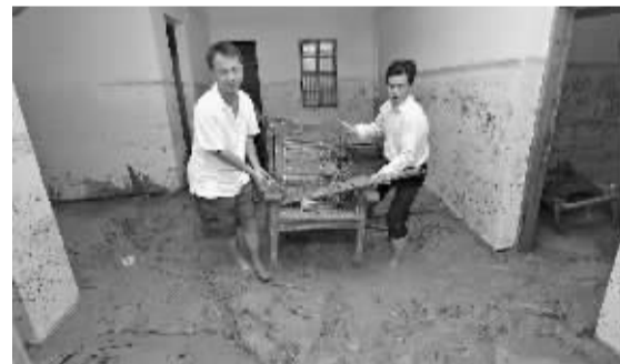
6月13日到14日,广东梅州北部的蕉岭县、平远县局部遭受大暴雨、特大暴雨袭击,部分乡镇山洪暴发,内涝严重,房屋和农田受浸,公路、通信、水利设施受损,造成数人伤亡。
