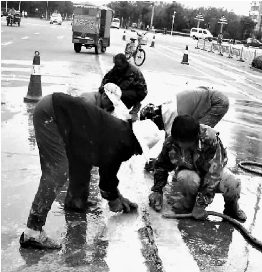
记者近日从交巡警支队了解到,我市将根据车流量的变化对淇滨区几个重要路段的车道分道线重新划分,保障新区车辆最大限度通行,方便司机们安全驾驶。图为工人们在九州路与兴鹤大街交叉路口清除准备改造的黄色车道分道线。 晨报记者 秦颖 见习记者 郭坤 摄
