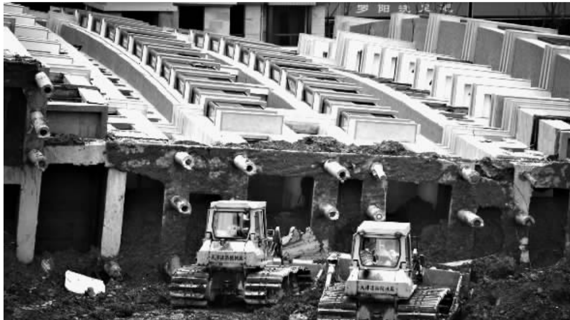
6月28日，两辆推土机在楼房倒塌现场清理堆积的土方。
