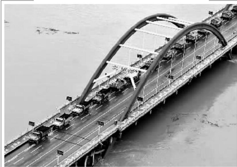
7月5日，30辆载重卡车停在柳州市文惠桥上压桥。为了确保广西柳州市文惠桥的安全，从7月4日夜间开始，柳州市用30辆载满石渣的卡车进行压桥，以确保这座中承式钢管混凝土拱桥的安全。
