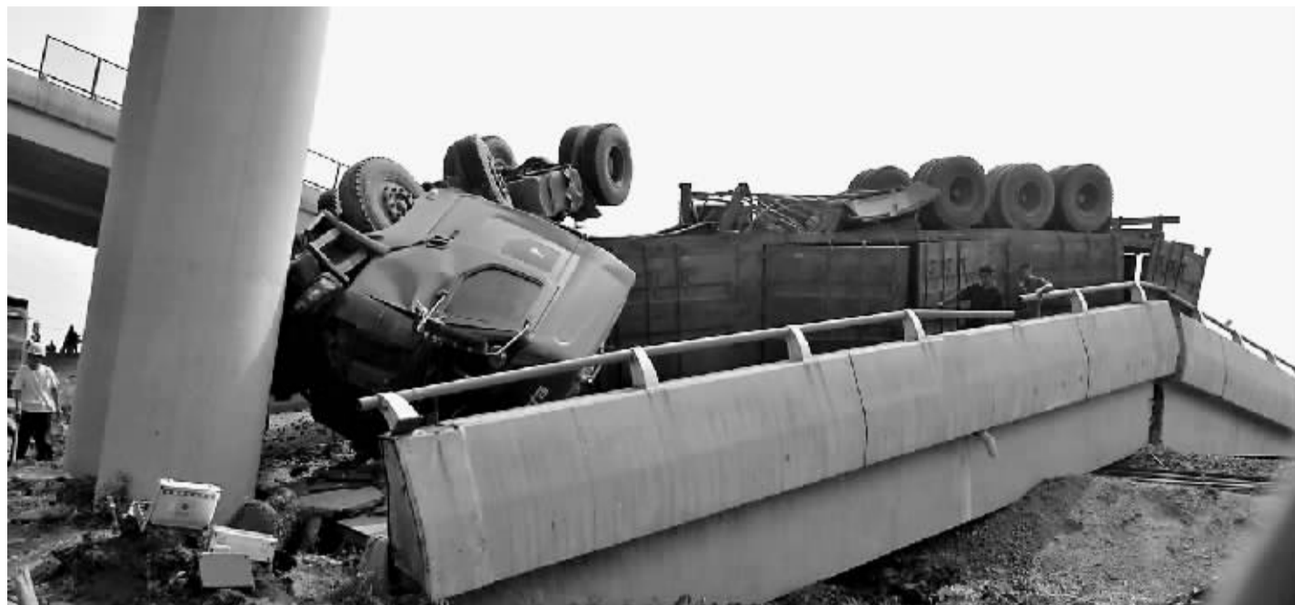
7月15日拍摄的津晋高速公路匝道桥坍塌事故现场。当日凌晨1时33分,津晋高速公路港塘收费站800米外匝道桥坍塌,5辆载货车坠落,造成6人死亡,4人受伤。天津市各相关部门迅速赶到现场实施救援清理。事故原因正在调查中。新华社发(王喜南 摄)
