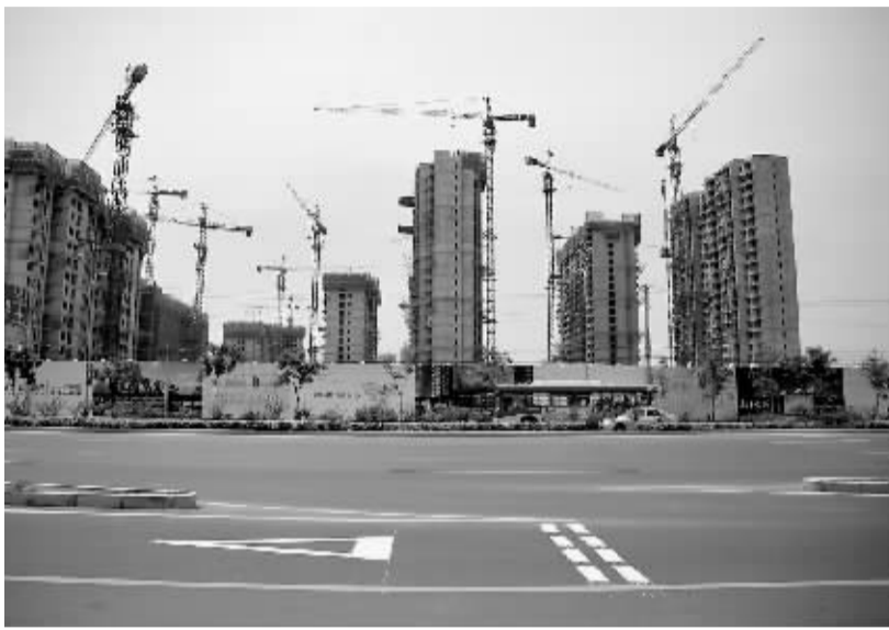
北京石景山区一在建楼盘施工现场。
